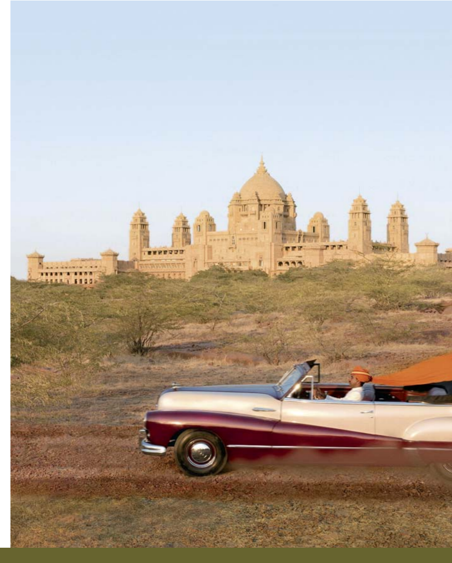
Schon aus der Ferne leuchten die rötlich-goldenen Mauern des Umaid Bhawan Palace den Besuchern Jodhpurs entgegen. Das gigantische Bauwerk, das auf den Hügeln über der Stadt liegt, ist einer der größten königlichen Paläste der Welt.
